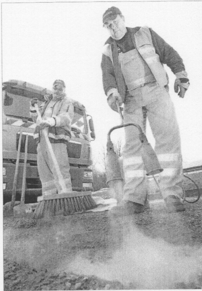
Auskehren, erhitzen, hineinschütten und festrütteln: Momentan werden Schlaglöcher mit so genanntem Kaltmischgut befüllt, bevor sie im Frühjahr wieder ausgefräst und langfristig repariert werden. Foto: ari
